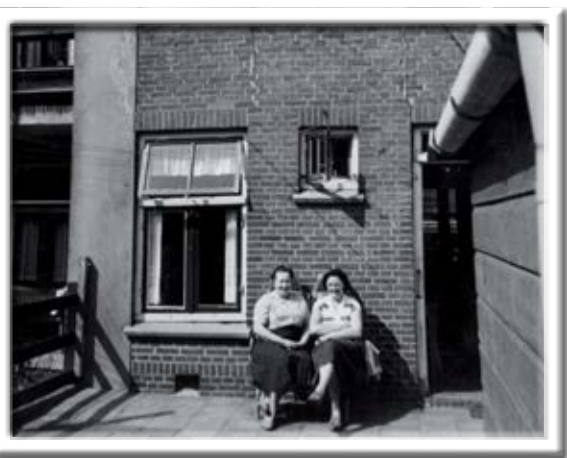
2.2 Twee vrouwen voor de achter gevel van complex Jaffa II. Deze huizen hadden al snel na de bouw de problemen met verzakkingen. Op de foto zijn er dan ook scheuren in het metselwerk te zien. Het complex is gesloopt en vervangen door nieuwbouw.
