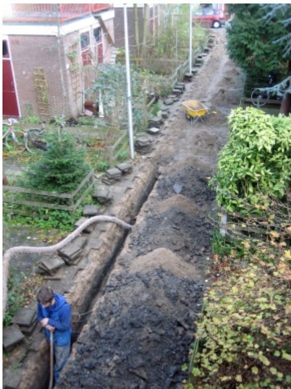
De drainageleiding in de binnenstraat wordt vernieuwd. Dit maakt onderdeel uit van de maatregelen om de benedenwoningen minder vochtig te maken.
