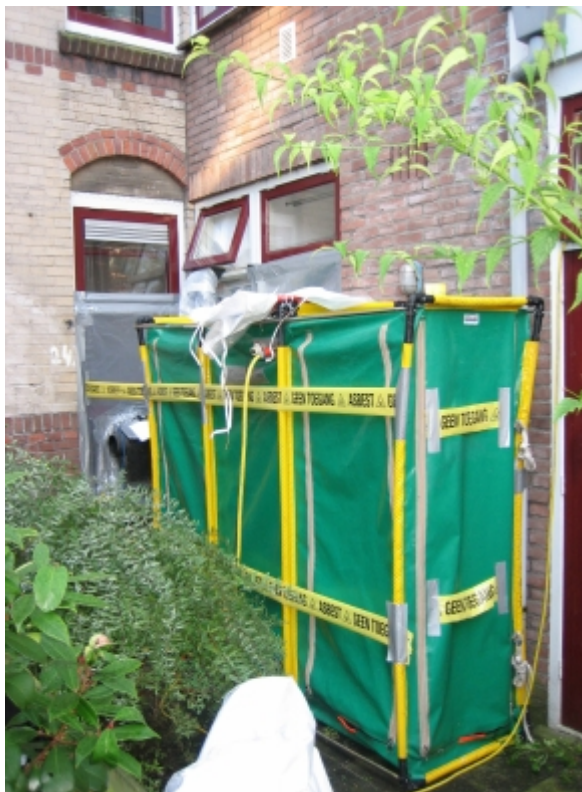
Asbestverwijdering benedenwoning Madoerastraat op 31 juli 2011. In nog twee andere woningen in het complex zijn dergelijke asbestvloertjes aangetroffen. De bewoners zijn op de hoogte.
