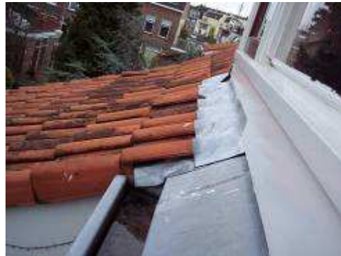
Afvoer water naar goot
