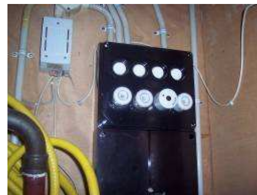
Groepenkast zonder aardlekschakelaar (bovenwoning)
