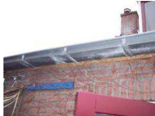
Aanslag op beugels en onderzijde goot
