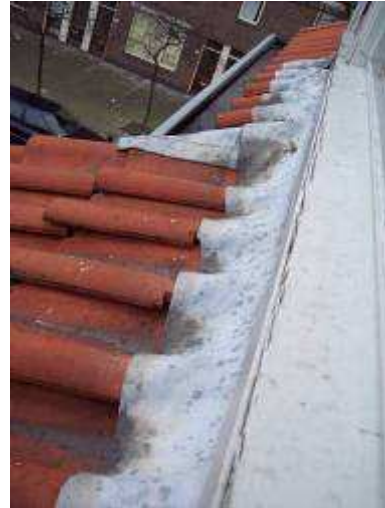
Naden ter plaatse van aansluiting aan triplex
